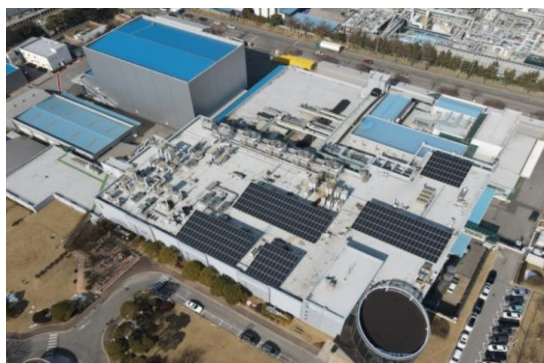
[천안캠퍼스 태양광발전 설비 설치 현황]
